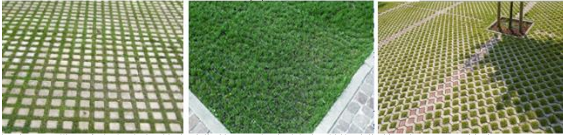
Cubetti o masselli con fughe larghe inerbite | Grigliati in materie plastiche inerbite | Grigliati in calcestruzzo a nido d'ape inerbite
