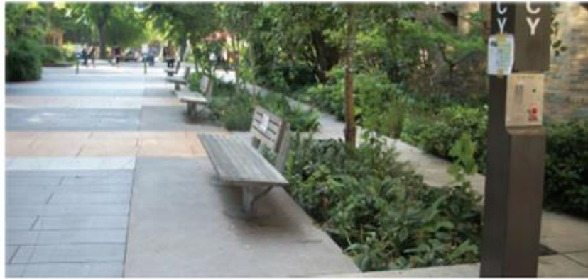
Figura 11. Esempio di strada senza cordoli per il convogliamento delle acque di pioggia nelle aree di infiltrazione. Fonte: Woods Ballard et al. 2015. "The SuDS Manual"
